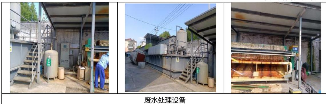
锦盛通过雨污分流处理技术使雨水能够经过雨水管网直接排到河道，污水需经过污水管网收集后，送到污水处理厂进行处理，水质合格后再排到河道里，这样能够避免河道被污染。
