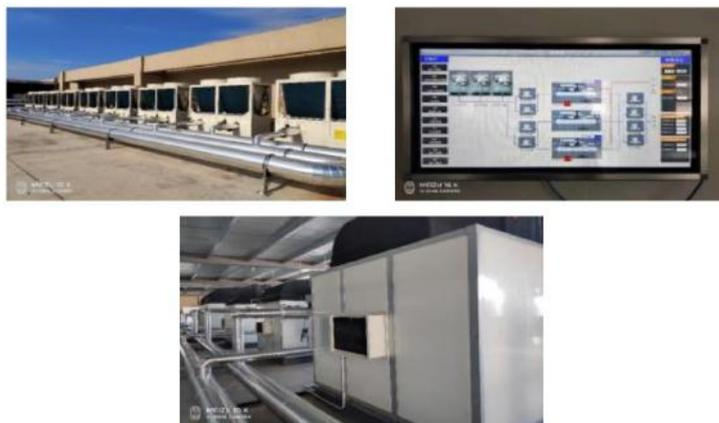
空调系统：所有冷水空调系统的水泵，都采用变频控制，送风系统电机采用西门子变频电机，都采用变频控制技术，节约电能达30%以上
