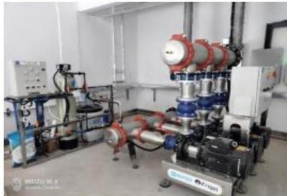
注塑冷却水系统：采用FRIGEL高效等焓加湿冷却器，采用全封闭冷却系统，与传统水塔比较最高可以节水95%，同时提高工艺用水的清洁度，降低维护费用达80%以上。水泵系统采用丹麦格兰富品牌，为世界第一品牌。整个系统节能下降40%以上。电能消耗减少30%以上。
