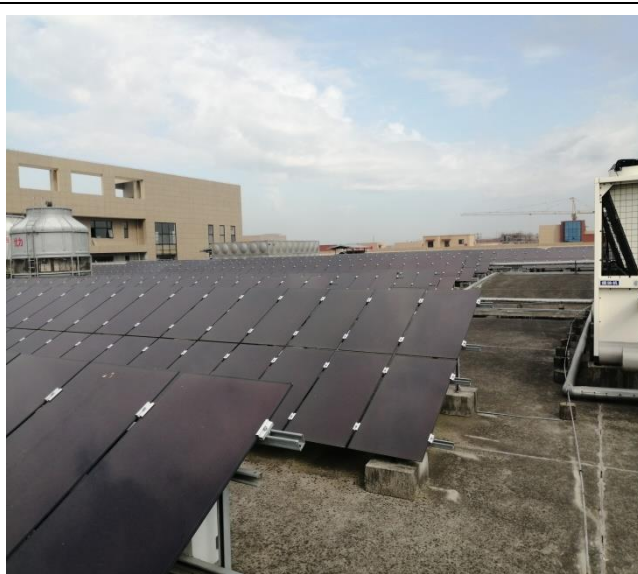
屋顶光伏太阳能板
