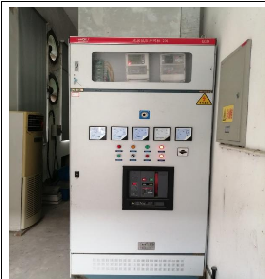
光伏低压配电柜
